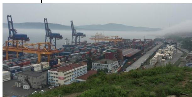
ウラジオストク商業港: 鉄道駅が港湾敷地内にあるためドレージ輸送の必要がなく、鉄道との積み替えがスムーズにできます。
