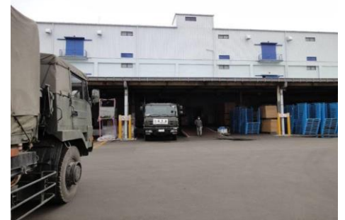
写真：東日本大震災において宮城県の物資拠点となった倉庫
