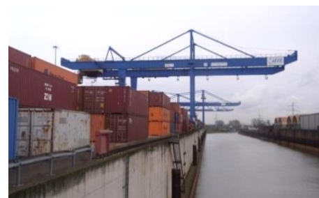
写真1：バージ専用クレーン
