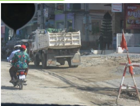
写真1：プノンペンの国道1号線の郊外接続部（約4kmがまだ工事中）
