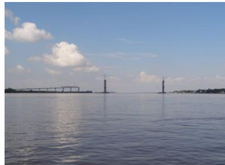
写真2：工事中の橋(2013年)
